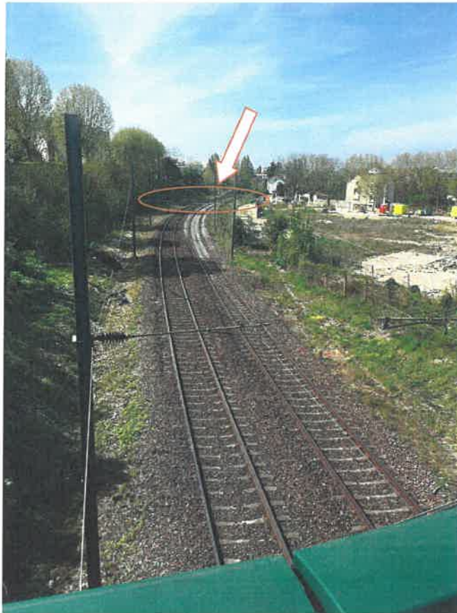
Vue du PN5 depuis le franchissement des voies par la RD247
