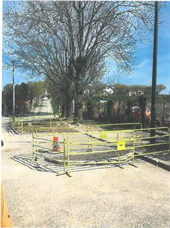
Avenue de la terrasse, vue depuis le PN5 rue du port
